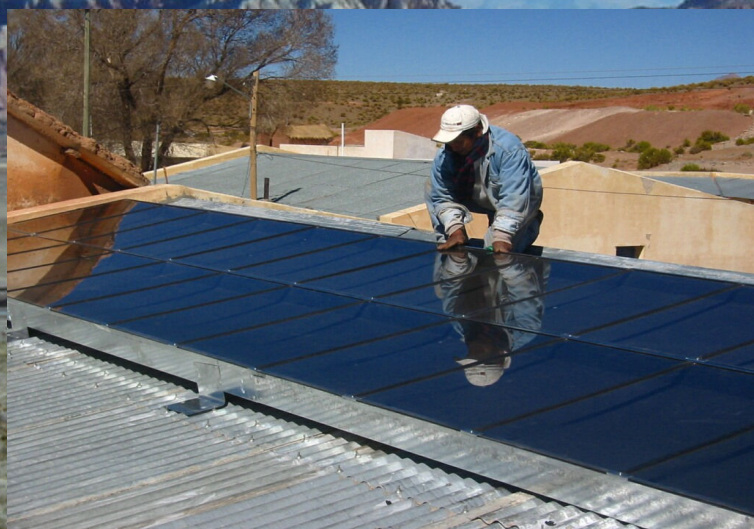
Bild 3: lokal gefertigter solarer Lufterwärmer
