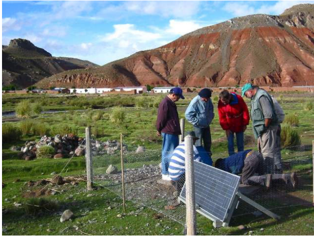
Abbildung 11: Solarpumpe zur Bewässerung und 1000 Liter Tank in Cienaga
