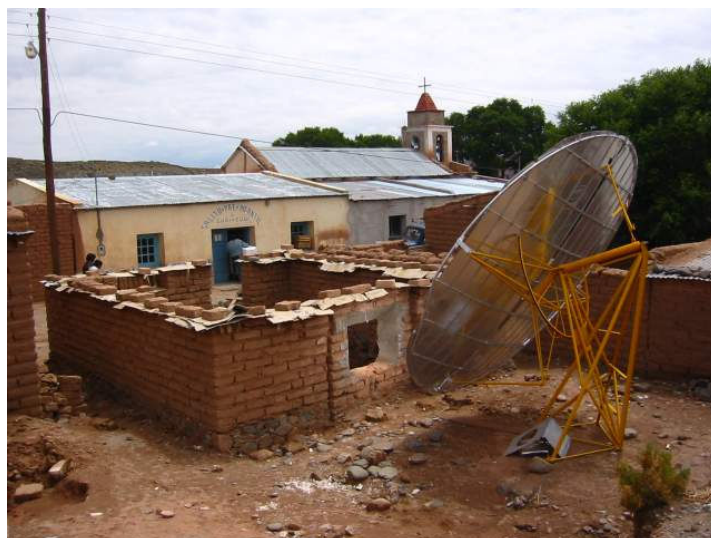
Abbildung 9: Solare Großküche im Bau in Cusi Cusi und kleiner Parabolkocher am Kindergarten.
