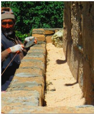
Figura 21: Aislamiento con aserraduras
