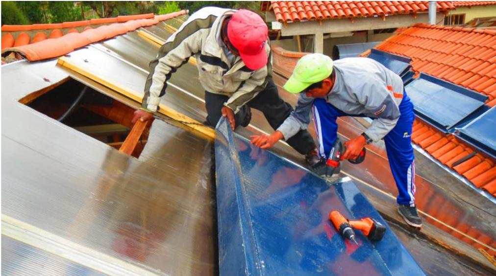
**Figura 18: instalación del calentador solar de aire**
