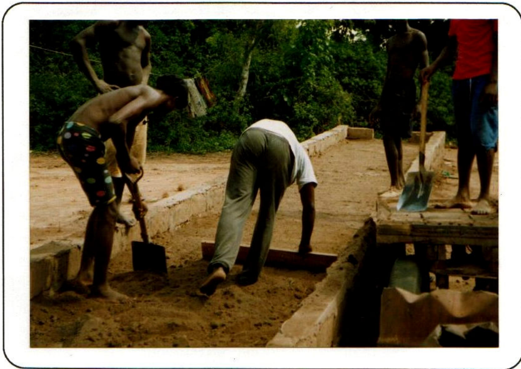
Der Innenraum wird bis zur oberen Steinreihe mit Erde aufgefüllt. Danach wird die Erde verdichtet und die 22 Meter lange Konstruktion mit Putz verkleidet.
