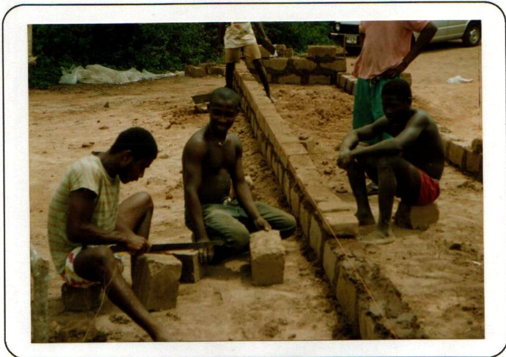
Mit 600 gestampften Lehmsteinen und etwas Mörtel beginnt der Bau des Trockners.
